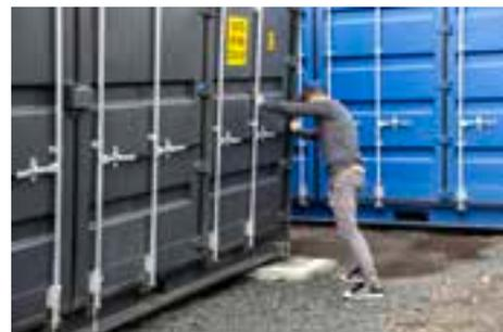
Maßarbeit: Die unteren Container müssen exakt auf den Fundamenten stehen, damit sie die Last des oberen tragen können.
